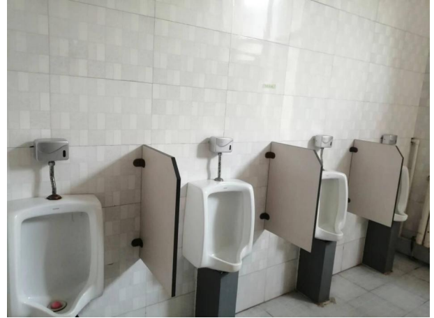
使用红外感应节水冲水设备
