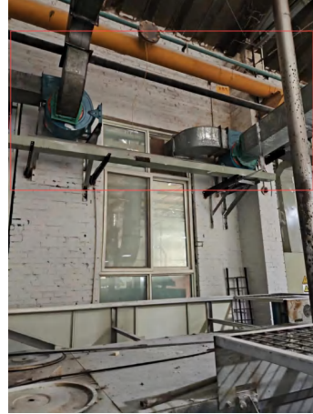
加热窑体余热收集管道离心风机
